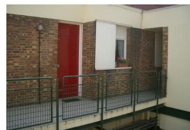
Fig.51; rue de l'Ourcq 2 ème étage, porte d'entrée et fenêtre équipée d'un volet
