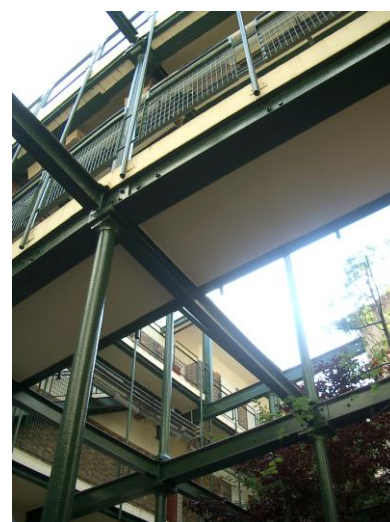
Fig.50 ; rue de l'Ourcq Vue en contre-plongée sur coursives et structure métallique
