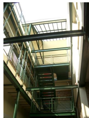
Fig.52; rue de l'Ourcq Une des cages d'escaliers principaux Intégrée à sa faille dans le bâti
