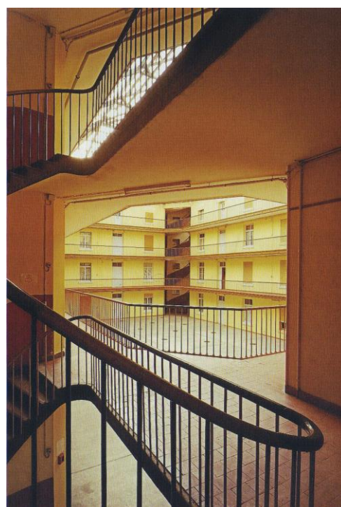
Fig.68, Familistère de Godin à Guise Vue depuis une cage d'escalier sur la cour
