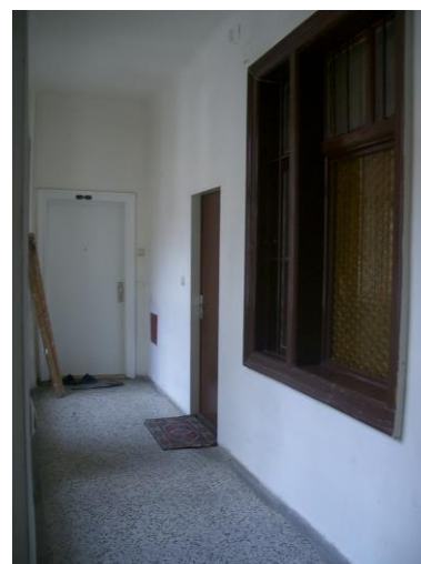
Fig.44 Vue sur une entrée en bout de galerie
